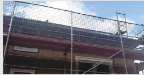
Cierre Vertical: Para impedir la caídas
